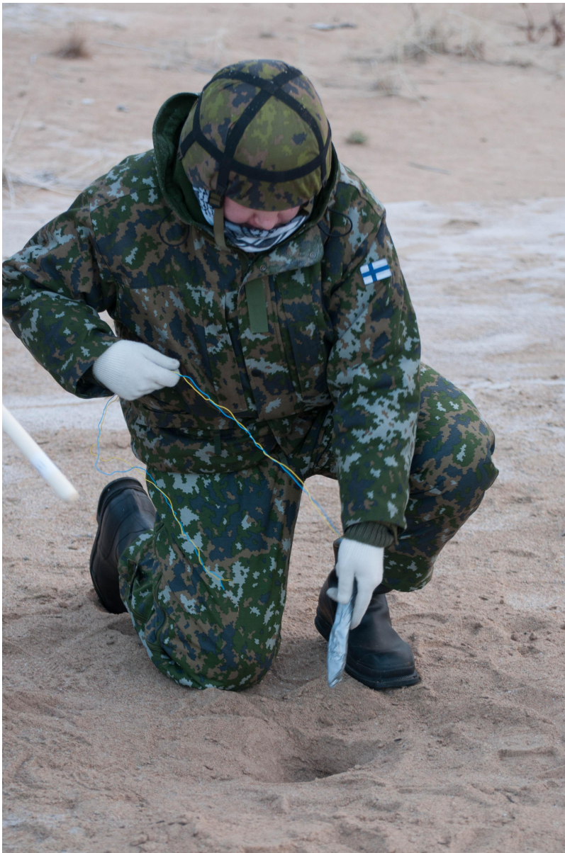
Mediavarusmies Korpaali Sauranen, asentamassa reikäpanosta Lohtajan hietikkoon. Panosta käytetään kiinteän maamassan rikkomiseen nopeuttamaan poteron valmistumista.
